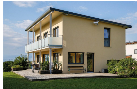
Pulldach mit Balkon
