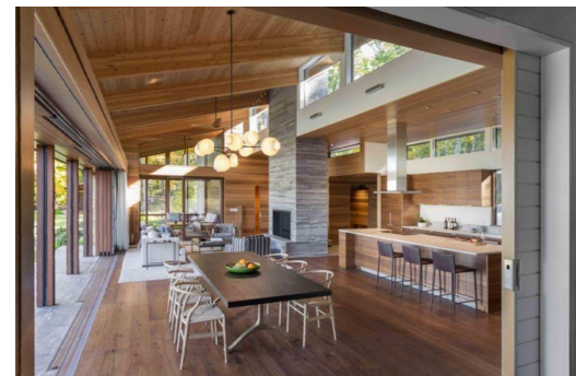
Pulldach mit Sichtbaren Sparren
